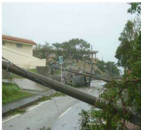
図 2-2 平成 18 年 台風 13 号 (石垣市)
