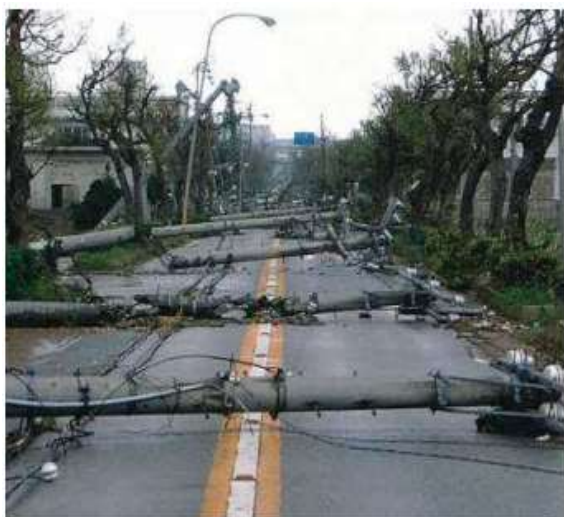
図 2-1 平成 15 年 台風 14 号 (宮古島市)
