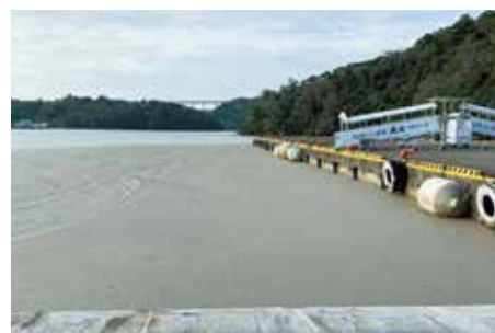
運天港の船着き場の状況
