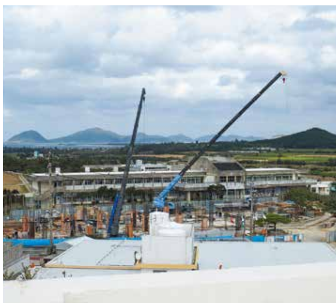
小学校校舎建設状況
